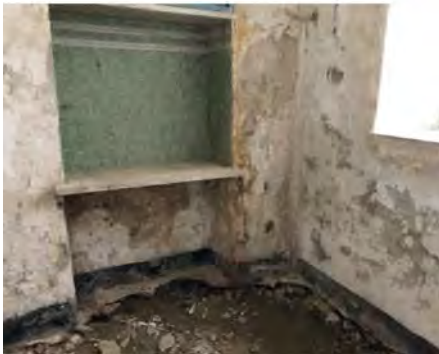
İç mekândan kuzey-doğu cephesi
