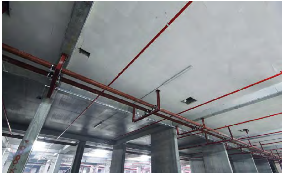
3S Firuze Konakları otopark tavanlarının ısı yalıtımında Multipor Isı Yalıtım Levhası kullanıldı.
