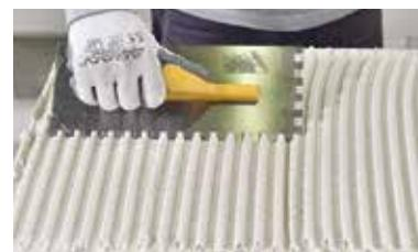
Yapıştırıcı, Multipor yüzeyine taraflı mala ile sürültür (diş derinliği 12 mm) veya çelik mala ile öbekler halinde uygulanır.
