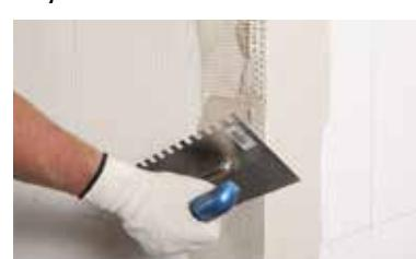
Köse noktalarına darbe dayanımı sağlamak için file donatılı pvc köşe profilleri yerleştirin.
