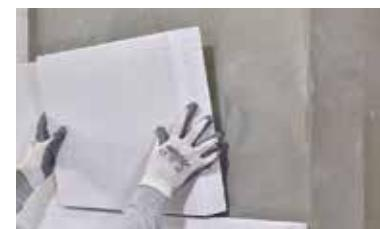
Yüzeyine Multipor yapıştırıcısı sürülmüş ısı yalıtım levhası, yanındaki ya da altındaki levhadan 2 cm uzağa yapıştırılır.
