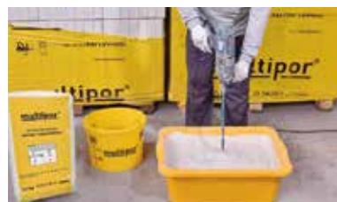
Multipor Cephe Yapıştırıcısı 25 kg'lık ağırlığa 8-9 litre su dolu bir kovaya boşaltılarak, düşük devirli bir karıştırıcı yardımıyla karıştırılır ve uygulamaya hazır hale getirilir.
