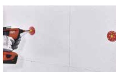
Yapıştırma işleminden 24 saat sonra uygun boyut ve sayıda sistem sağlayıcısının onayladığı dübeller ile levhaların mekanik tespiti yapılır.
