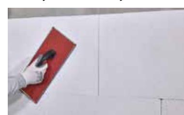
Levhaların birleşim yerleri, gerekliyse Multipor rendesi ile düzeltılır.
