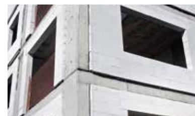
Ytong 0,09 duvar blokları, betonarme iskeleti tamamlanmış bir yapıda, Multipor levhası ve yapıştırıcısı kalınlığı kadar dışarı taşırlarak Ytong örgü tutkulu ile örülür.
