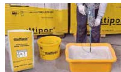
Multipor Cephe Yapıştırıcısı 25 kg'lık ağırlığa 8-9 litre su dolu bir kovaya boşaltılarak, düşük devirli bir karıştırıcı yardımıyla karıştırılır ve yapıştırma hazır hale getirilir.
