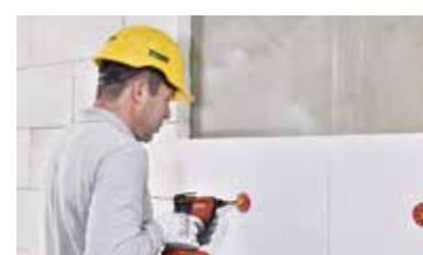
Yapıştırma işleminden 24 saat sonra uygun boyut ve sayıda sistem sağlayıcısının onayladığı dübeller ile levhaların mekanik tespiti yapılır.
