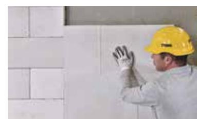
Multipor ısı yalıtılmış levhalar yanındaki veya altındaki levhaya doğru kaydırılır. Levhaların derz yerlerinde yapıştırıcı bulunmadığından emin olun.
