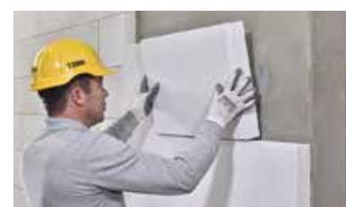
Yüzeyine Multipor yapıştırıcısı sürülmüş Multipor ısı yalıtılmış levhası, yanındaki ya da altındaki levhadan 2 cm uzaga yapıştırılır.
