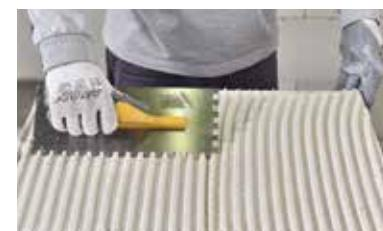
Yapıştırıcı, Multipor yüzeyine taraklı mala ile sürüller (diş derinliği 12 mm) veya çelik mala ile öbekler halinde uygulanır.
