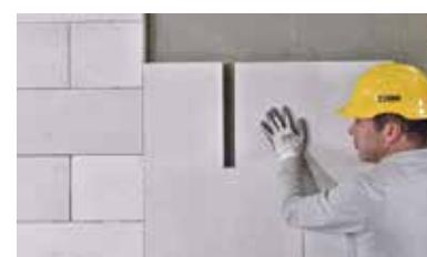
Yapıştırılan Multipor ısı yalıtılmış levhası avuç içi yardımı ile bastırılarak yüzeye tutundurulur.
