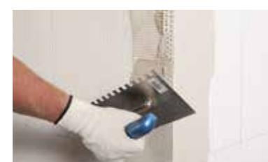
Köşe noktalarına darbe dayanımı sağlamak için özel file donatılı pvc köşe profilleri yerleştirin.
