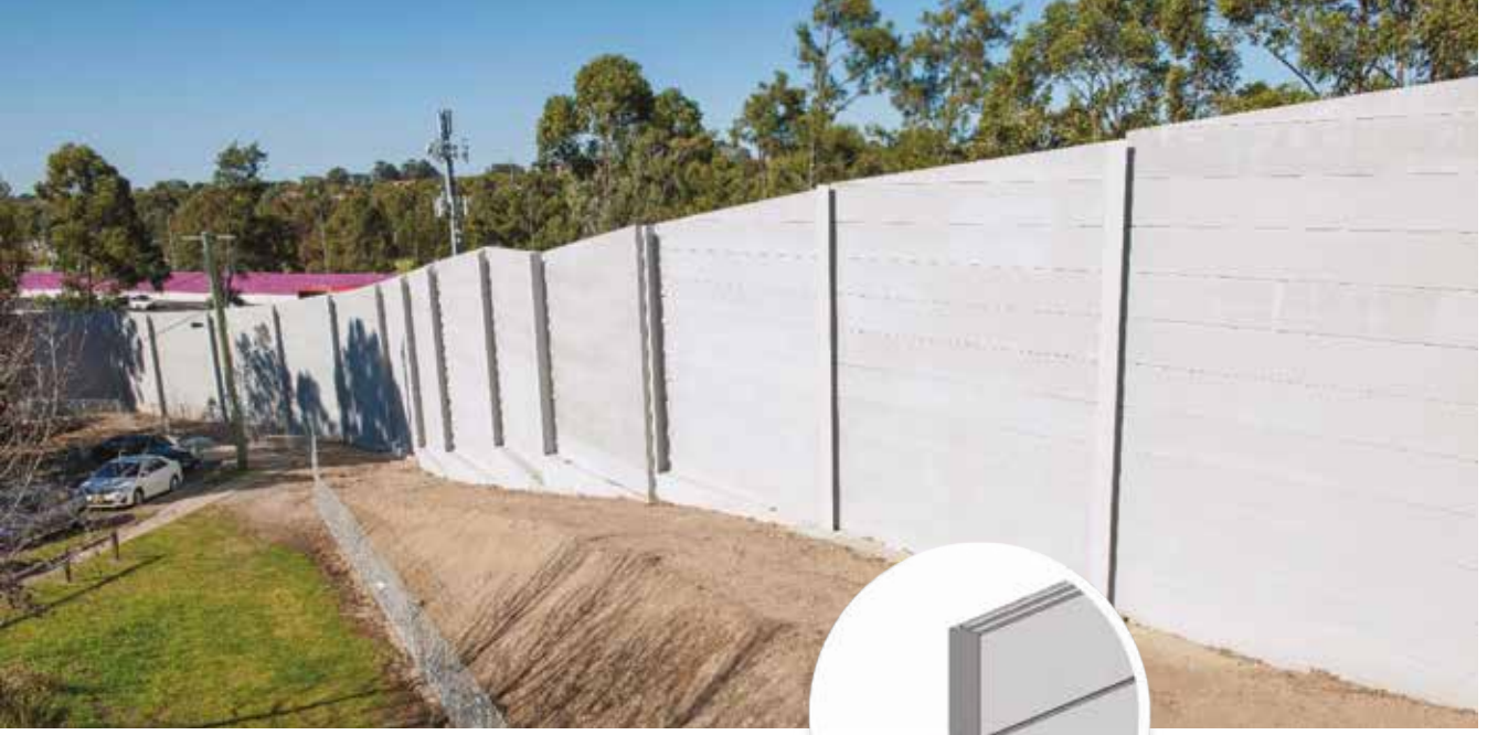
Şekil 3. Ytong panellerin lambazivana profil yapısı
