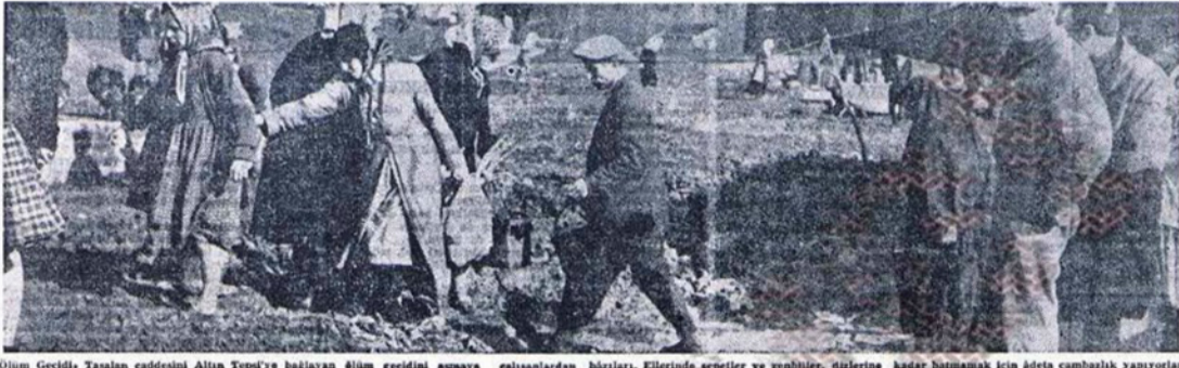
Yetersiz altyapı sonucu oluşan çamur ve devamında salgın hastalıklar
