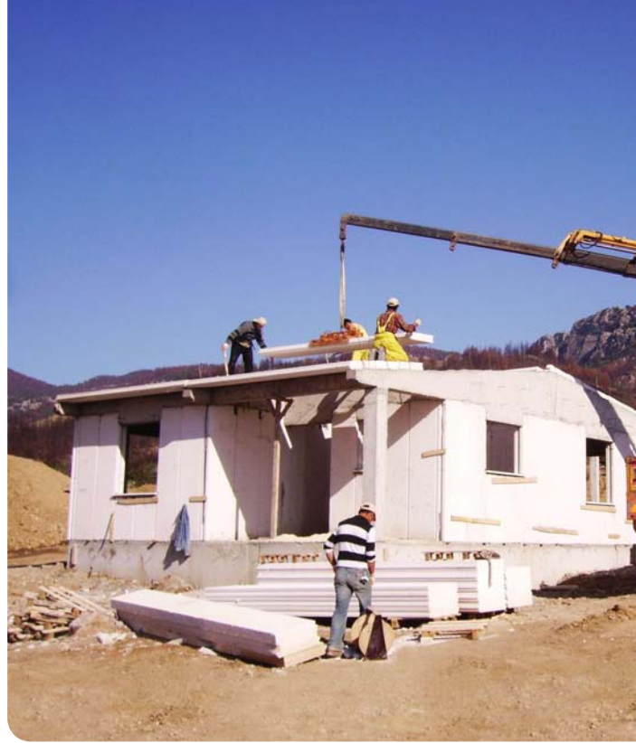
Bölgede ilk etapta, 41 konutun inşaatı 2 ay gibi kısa sürede tamamlandı.
